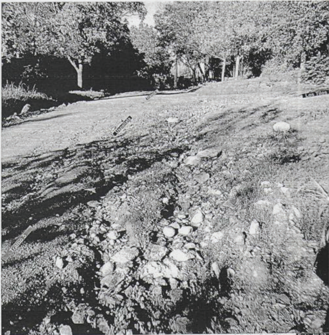
Calle Uspallata 5° tramo Foto N° 23
