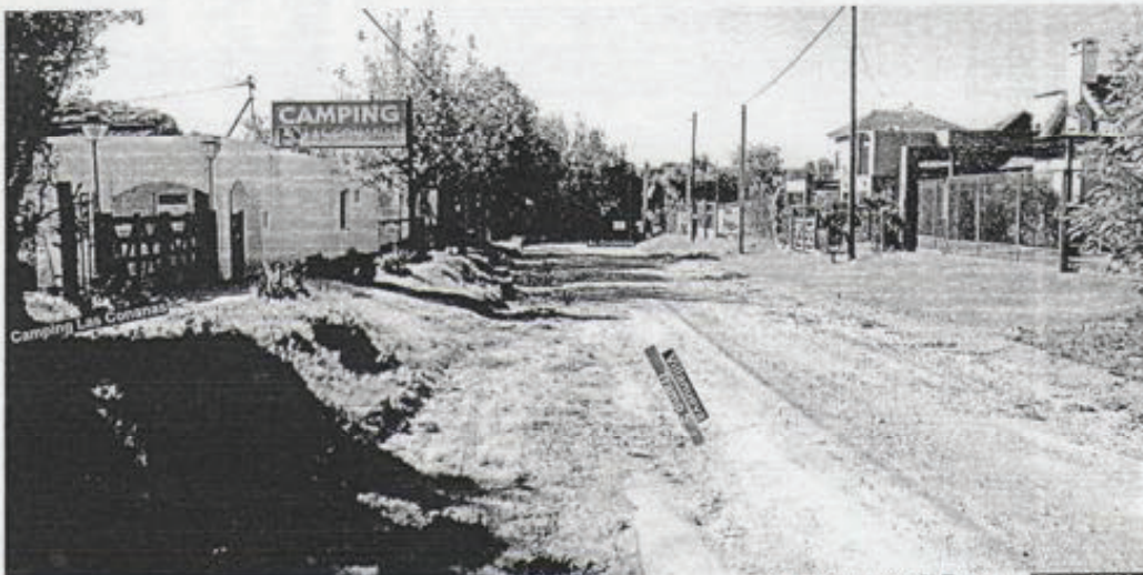
Calle Villanueva 5° Tramo Foto N°21
