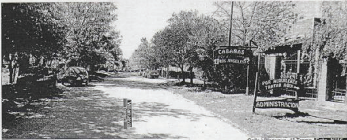
Calle Villanueva - 1° Tramo Foto N°16
