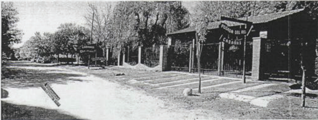
Calle Villanueva 1° Tramo Foto N°15
