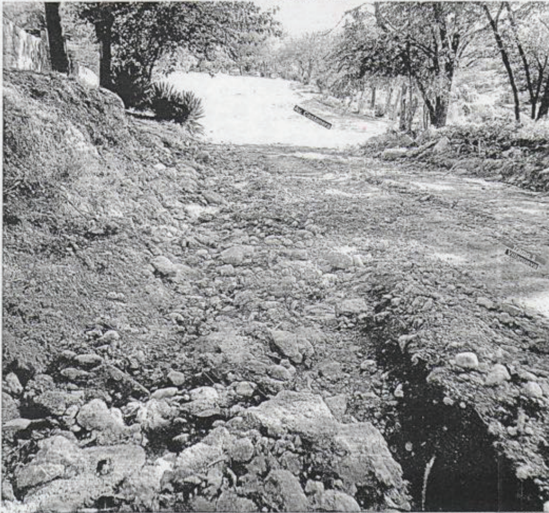
Calle Uspallata 5° tramo Foto N° 24
