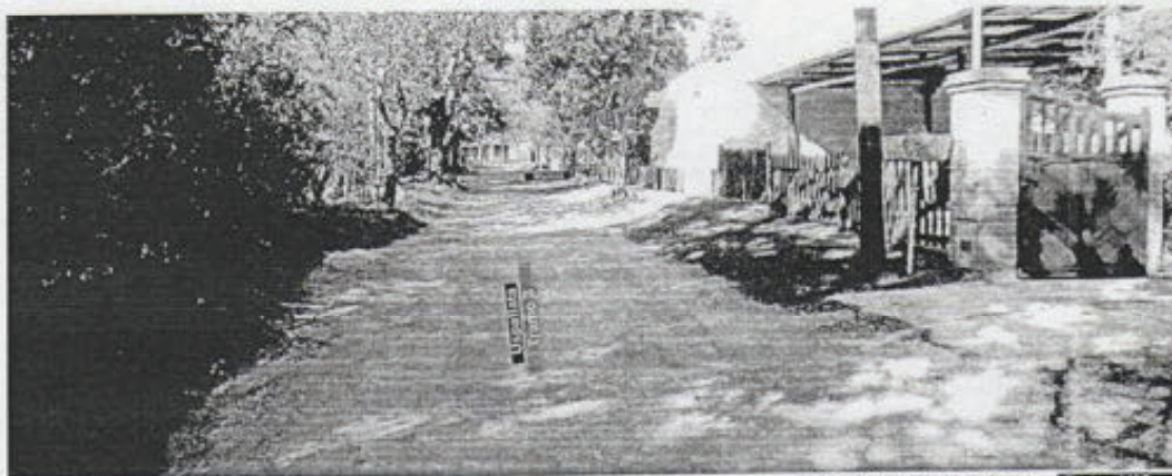
Tramo 3: Calle Uspallata Foto N°9
