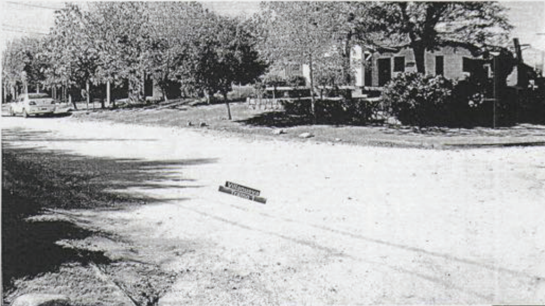
Comienzo del 1° Tramo: Calle Villanueva esq. Merlo Foto N°14
